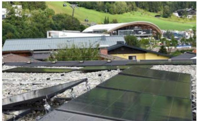
Am Dach ist eine 352 m<sup>2</sup> große Photovoltaikanlage verbaut (dieses Bild entstand bei der Montage der einzelnen Module). Im Hintergrund die Talstation des nahegelegenen „areitXpress“.
